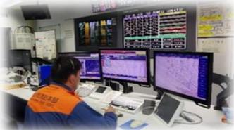
火災・救急・救助等の災害通報は、情報指令課で受信され、指令台によって119番通報の受付と同時にコンピュータによる処理が開始されます。通報内容から、発信地表示システム、地図検索装置により通報場所や付近の地図が自動的に表示されます。
