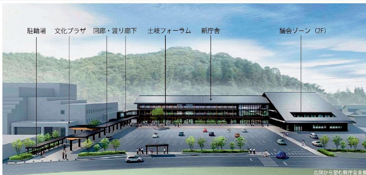
北側から望む新庁舎全景
