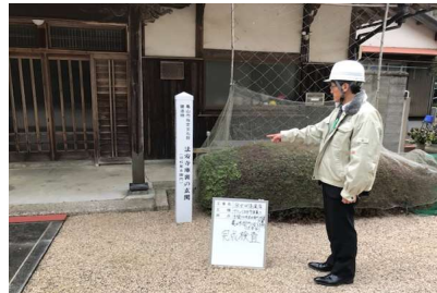
■工事完成【撮影：令和2年3月】
