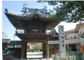
■工事完成【撮影:平成30年3月】
