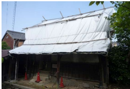
■工事着工前【撮影：平成31年4月】
