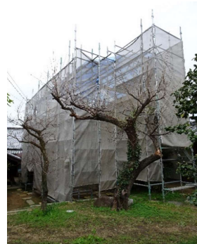
■現在工事中【撮影：令和元年11月】
