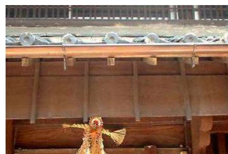
安政4年(1857)の棟札が残る建造物
