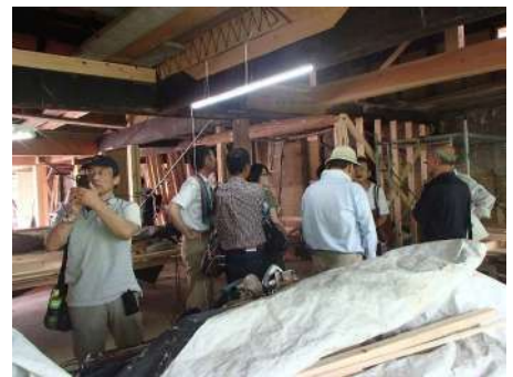
■奈良県五條市伝建地区改修工事現場研修
