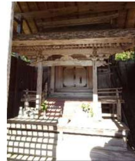
■坂本神社（覆屋内の小堂）
