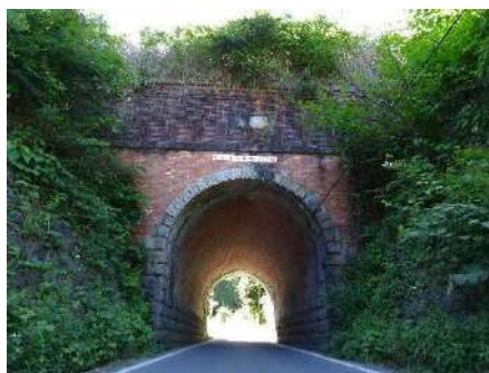
■大和街道架道橋
