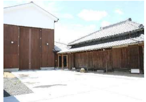
■山車収蔵展示棟(左)、 旧三谷家住宅離れ (関の山車会館離れ)(右)
