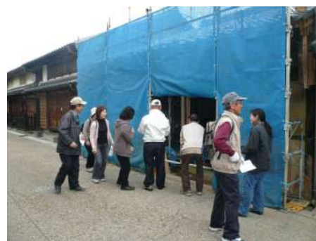
■修理現場公開
