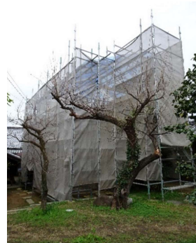
■現在工事中【撮影：令和元年11月】
