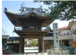
■工事完成【撮影:平成30年3月】
