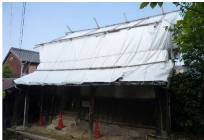
■工事着工前【撮影：平成31年4月】
