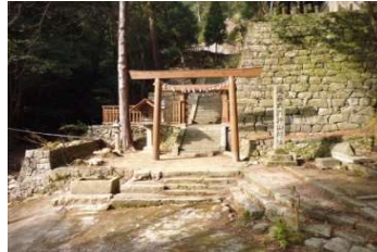
■工事完了【撮影:平成27年3月】
