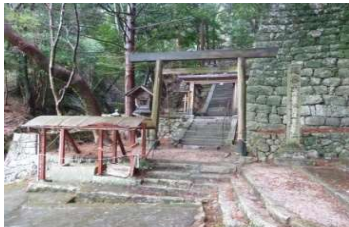
■工事着工前【撮影:平成26年12月】
