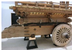
■中町三番町山車の車軸破損状況 【撮影: 令和元年10月】
