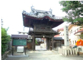
■工事着工前【撮影:平成29年7月】
