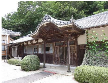
■工事着工前【撮影：令和2年1月】
