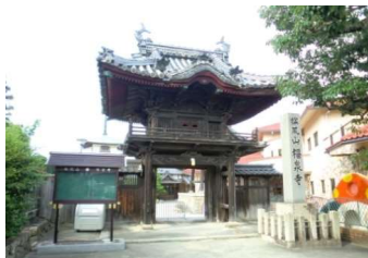
■工事着工前【撮影：平成29年7月】
