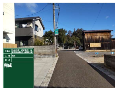
■工事完成【撮影:令和6年2月】
