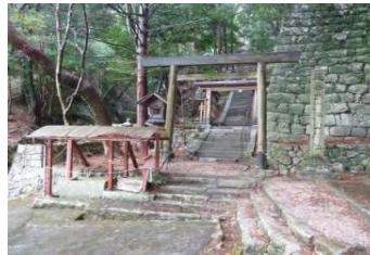
■工事完了【撮影：平成27年3月】
