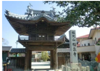
■工事完成【撮影：平成30年3月】
