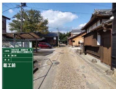
■工事着工前【撮影:令和5年9月】
