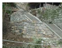
工事完了 平成27年3月
