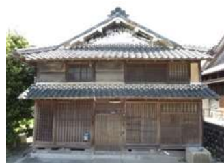
工事改修前（平成27年9月）
