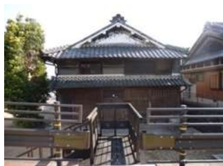
工事改修後（平成28年3月）
