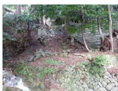
片山神社 石段整備 工事着工前 平成26年12月
