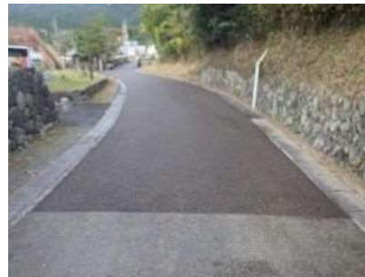
■ 工事完成【撮影: 令和7年11月】
