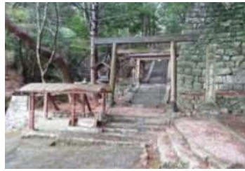
■ 工事完了【撮影:平成27年3月】
