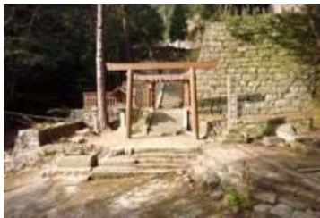
■ 工事着工前【撮影:平成26年12月】
