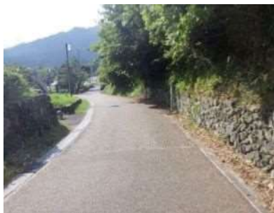
■ 工事着工前【撮影: 令和7年8月】
