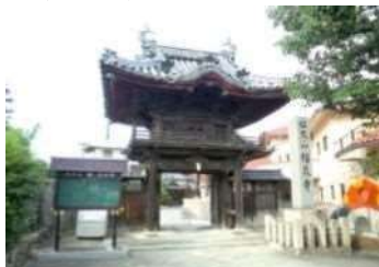
■ 工事着工前【撮影:平成29年7月】
