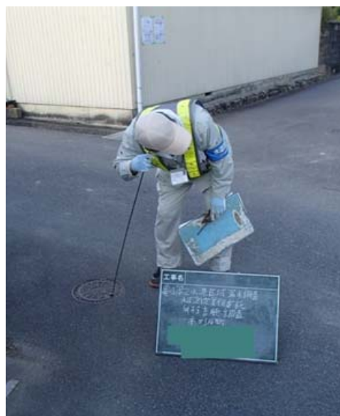
漏水調査の作業風景
