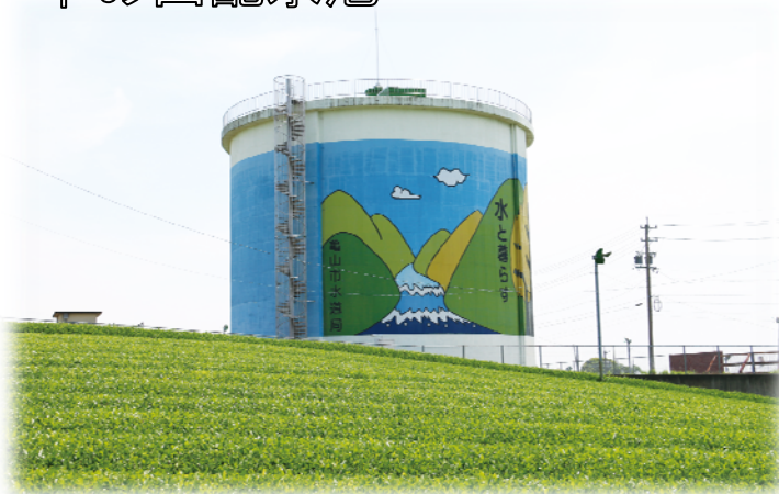
中の山配水池
