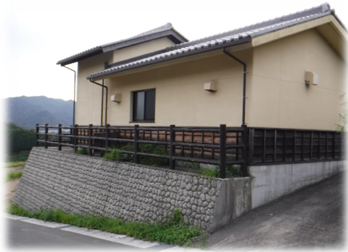
坂本加圧ポンプ場
