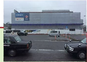
工事が進む新図書館
