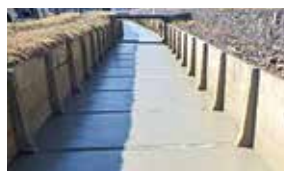
底張りコンクリート施工後
