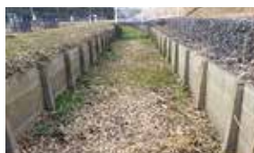
底張りコンクリート施工前
