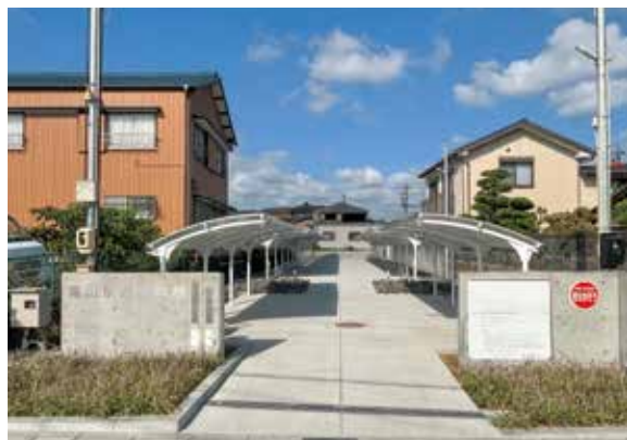
亀山駅西駐輪場(工事中:9月16日時点)
