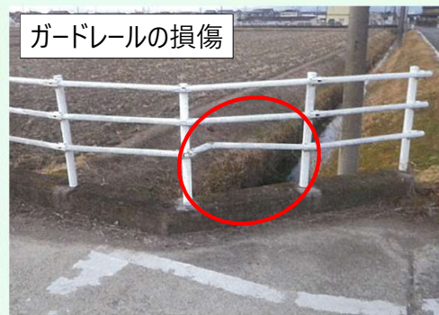
排水施設、交通安全 施設修繕工事
