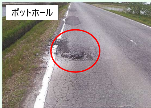
舗装補修工事
