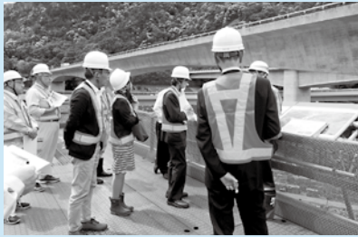
新名神高速道路の亀山西ジャンクションランプ工事現場
