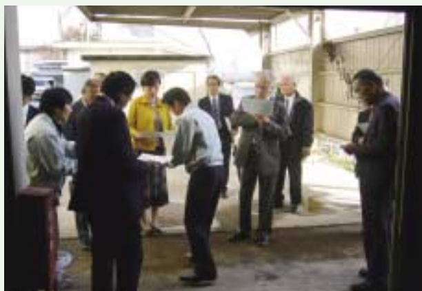
市庁舎内空調機、熱源機更新工事現場
