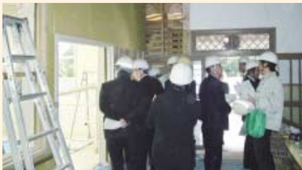
白川小学校耐震改修工事現場
