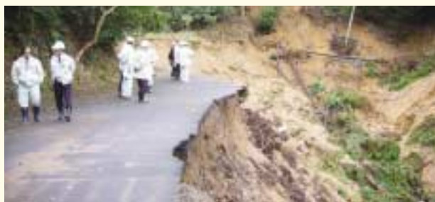
鈴鹿南線災害復旧現場
