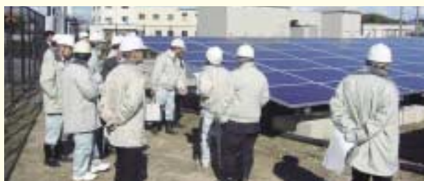
ZTVメガソーラー設置現場
