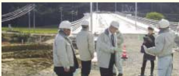
和賀白川線工事現場
