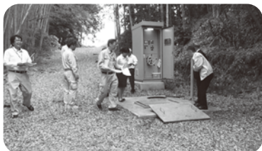
亀山配水池（野村一丁目）緊急遮断弁設置工事
