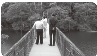
聖橋（関町新所）修繕工事
