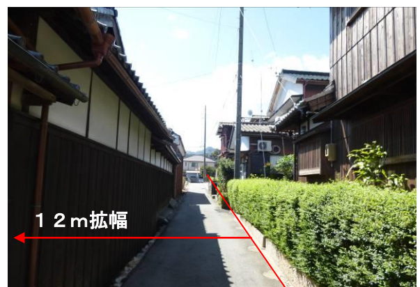
② 都市計画道路として12mに拡幅予定の路地
