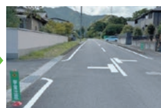
改善の事例(路面標示・ポールの設置)
