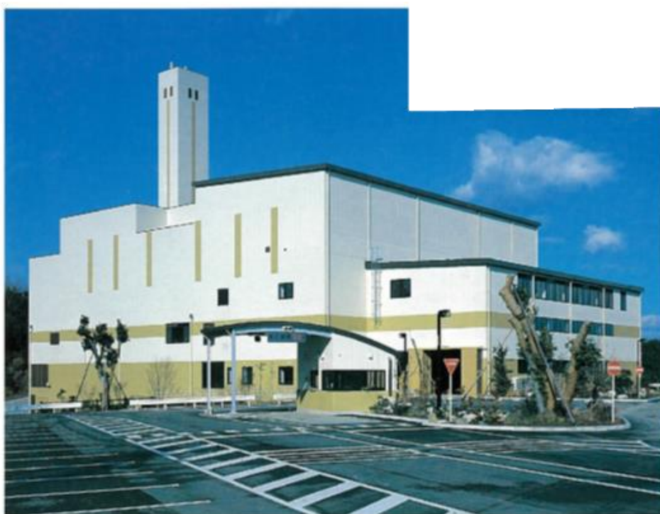
図2-1 亀山市総合環境センター全景写真
