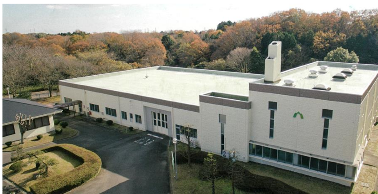
図２－２ 亀山市衛生公苑全景写真
