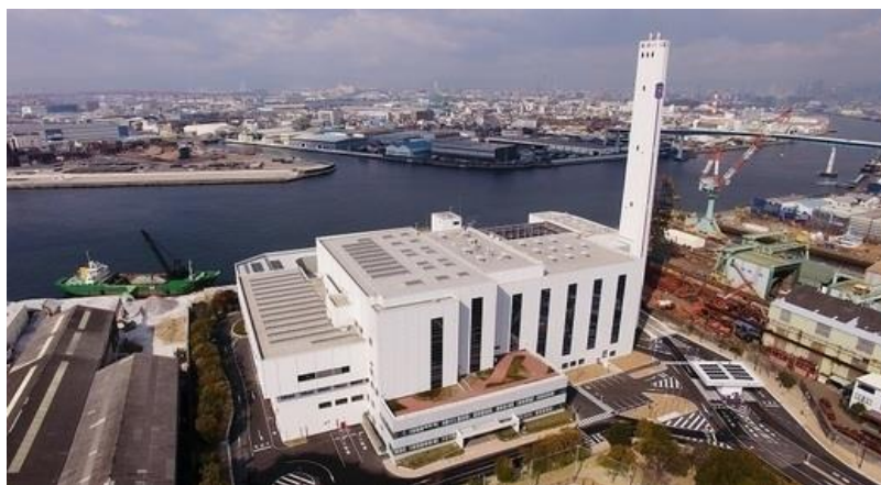
図3-5 大阪広域環境施設組合住之江工場
