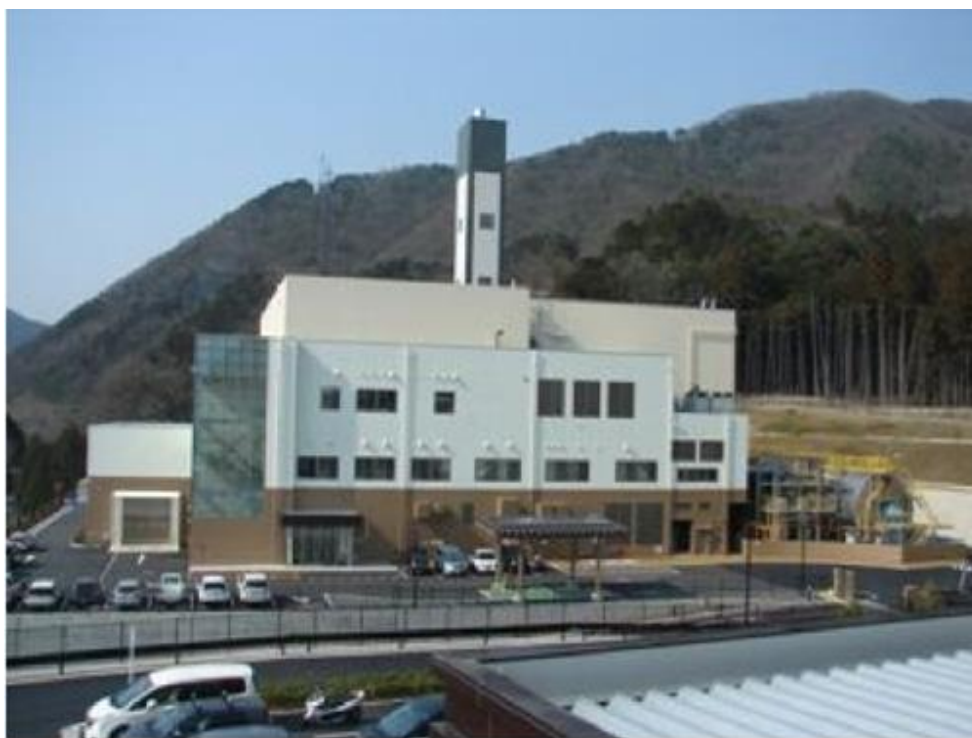
図３－４ 南但クリーンセンター全景写真
