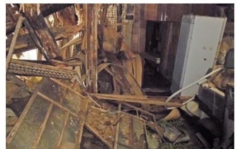
家屋が傾き、雨漏りや建具の損傷が見られた。
