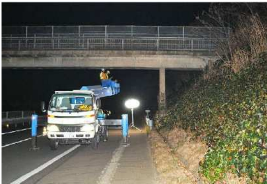
<橋りょう点検の作業状況（例：高速道路を跨ぐ橋りょう）>
