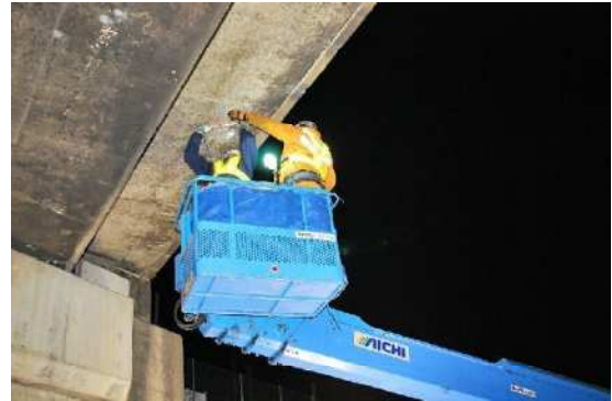
<橋りょう点検の作業状況（例：高速道路を跨ぐ橋りょう）>
