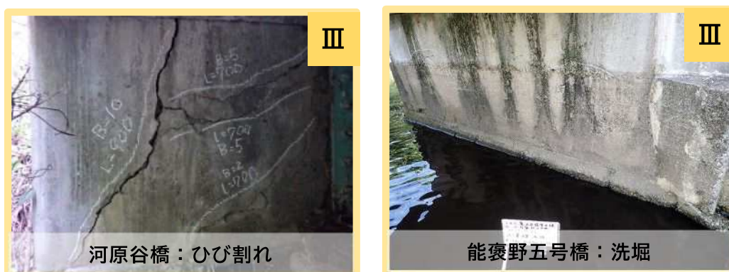
図 13 下部工の判定区分Ⅲの例
