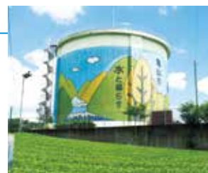
中の山配水池
