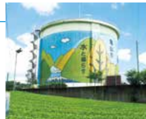
中の山配水池
