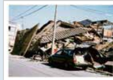
一般財団法人消防防災科学センター提供 阪神淡路大震災による家屋倒壊の様子
