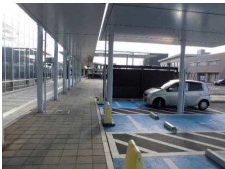
障がい者用駐車スペース(観音寺市)
