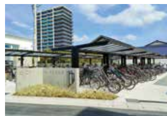
亀山駅東駐輪場
