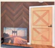
三重県産の杉の羽目板を亀山にある作業場で、一枚一枚手作業でヴィンテージ風に加工したウッドパネルを作っています。
