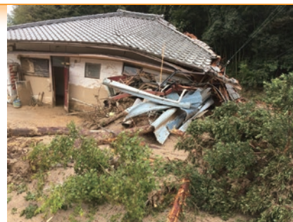
写真出典：多気町総務課防災係 土砂災害の被害にあった多気町長谷地区の様子
