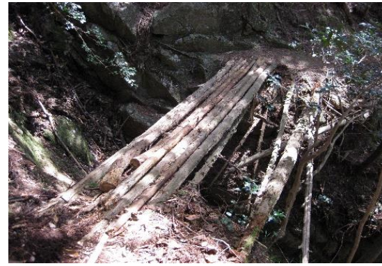
白谷コース 古い木の橋1(応急処理後)(24)
