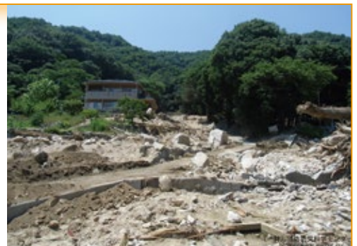
平成30年7月豪雨での被害状況 写真出典: (一財)消防防災科学センター
