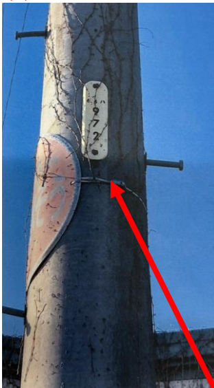
元電柱の電柱番号札 （中部電力電柱番号）
