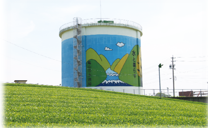
中の山配水池
