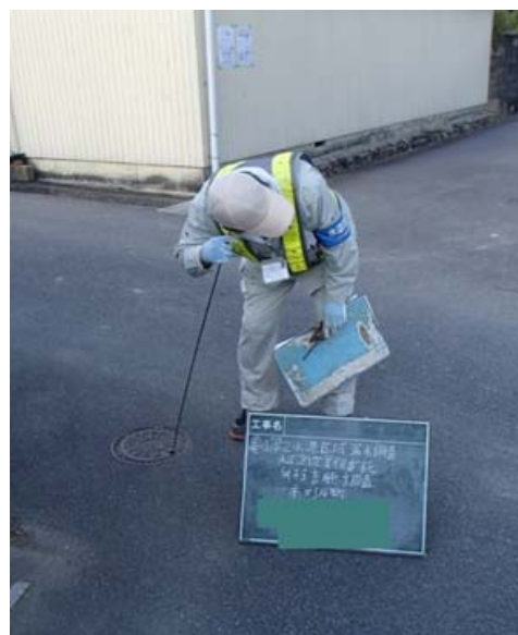
漏水調査の作業風景
