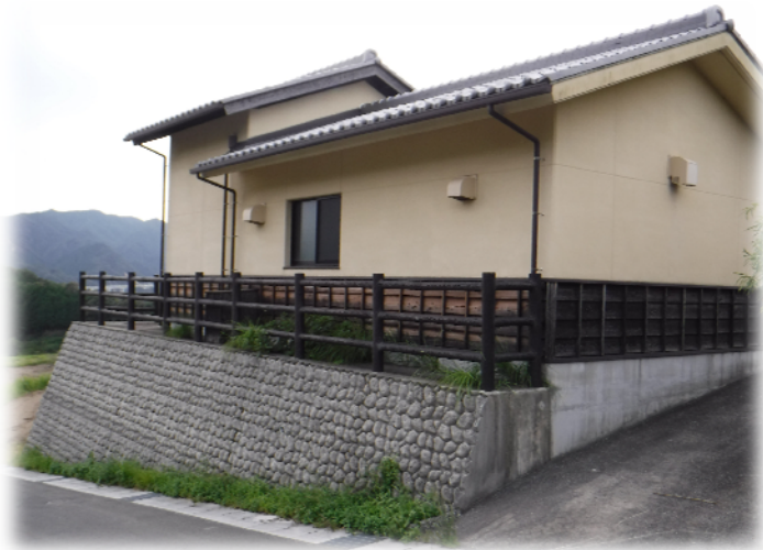
坂本加圧ポンプ場
