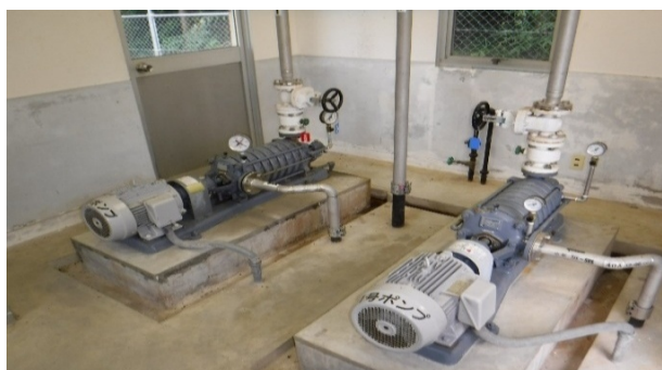
関南部加圧ポンプ
