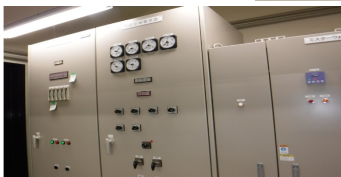
加圧ポンプ制御盤
