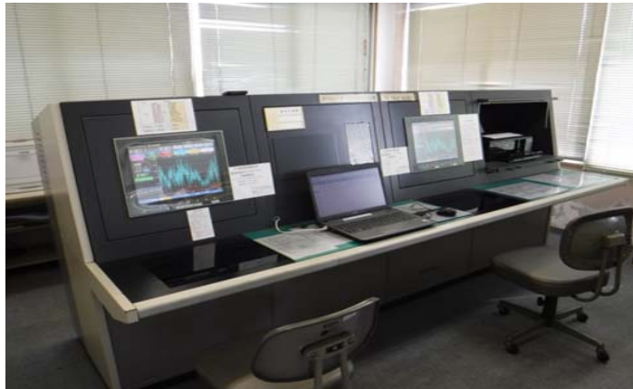
関第 2 水源地の中央監視制御装置
