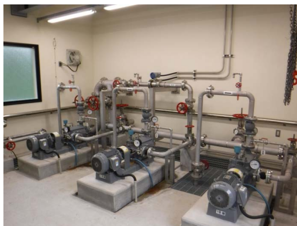
省エネルギー型のポンプ（坂本加圧ポンプ室）
