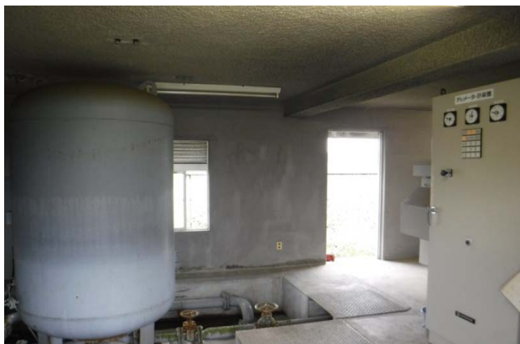
川崎加圧ポンプ
