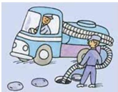
浄化槽内に溜まった汚泥などの引き抜きと機器類の洗浄などを行います（年に1回、全ばつ気方式は6カ月に1回以上）。清掃を行わないと、汚泥などが排水と一緒に流れ出し、し尿をそのまま放流するのと同じ結果になります。
