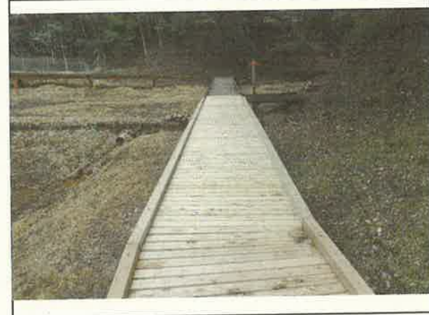
写真4 交換後（令和5年3月18日）約12m
