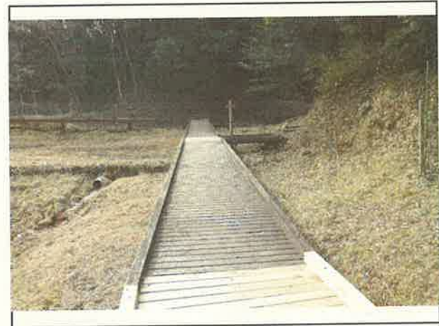
写真3 八橋交換前（令和5年3月17日）
