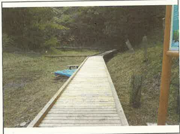
写真2 交換後（令和4年11月5日）約12m
