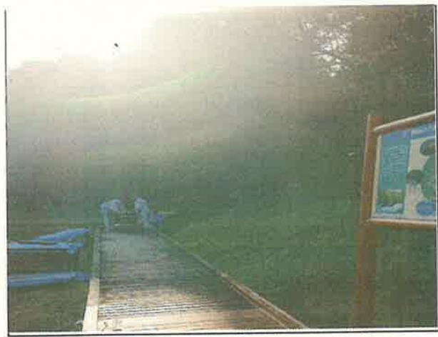
写真1 八橋交換前（令和4年11月4日）
