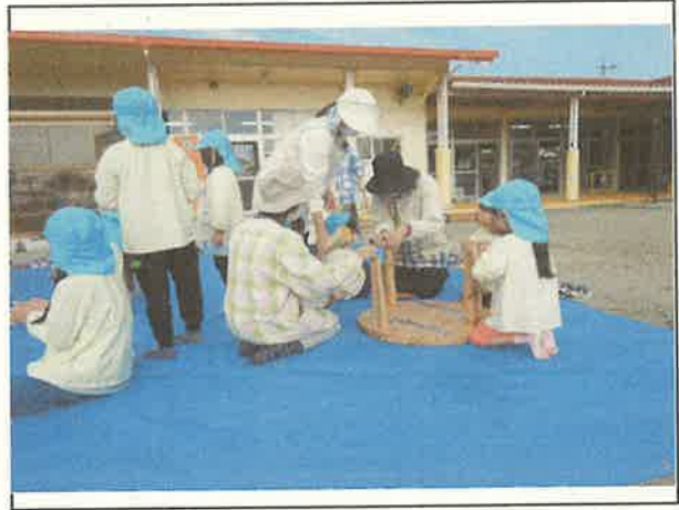
写真2 テーブル、ベンチ組立
