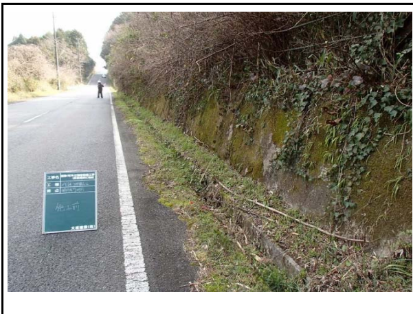
写真3 市道野村楠平尾線その2(伐採前)
