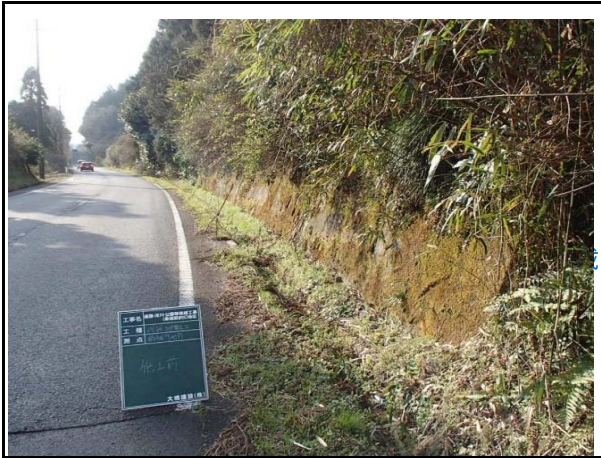
写真1 市道野村楠平尾線その1(伐採前)
