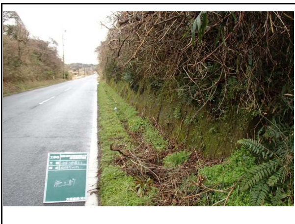
写真5 市道野村楠平尾線その3(伐採前)
