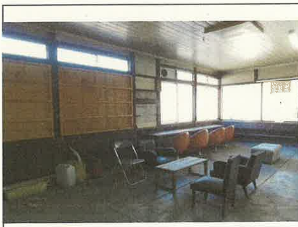
写真5 JR加太駅舎 旧事務室
