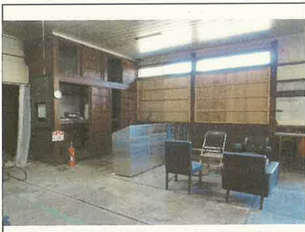
写真3 JR加太駅舎 旧事務室
