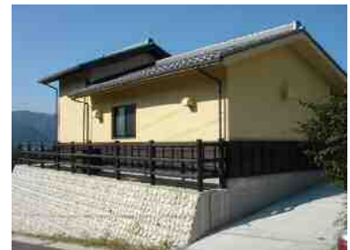
棚田の景観に合わせた 坂本ポンプ室
