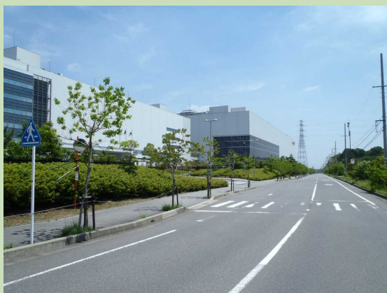
●緑地帯によるゆとりある空間を設け、圧迫感を軽減している。(白木町)
