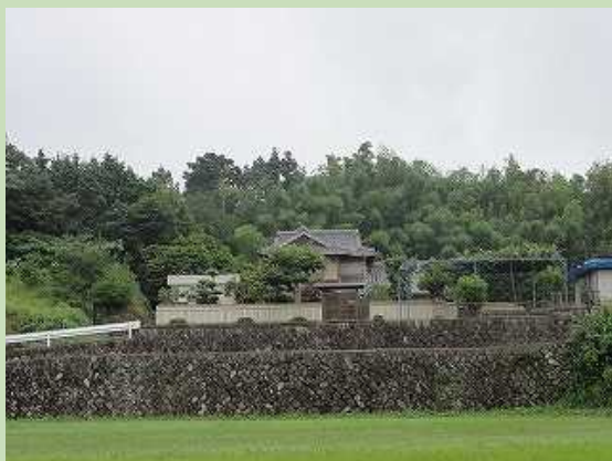
●低層の建築物とし、背景のまとまりのある樹木の高さを超えないよう配慮している。(両尾町)
