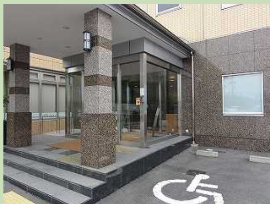
●低層部に石材を用いている。(小野町)
