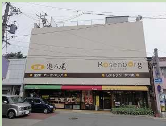
● 庇部分にアクセントとなる色彩を用いることで、賑わいを演出している。(御幸町)
