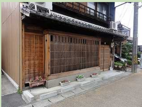
●木材を用いて、周囲の歴史的町並みに調和するように配慮している。(西町)
