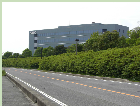
●緑地帯によるゆとりある空間を設け、圧迫感を軽減している。(愛知県日進市)
