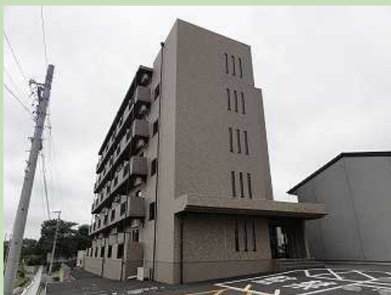
●屋外階段を建築物と一体化させ、目立たなくなるよう配慮している。(羽若町)
