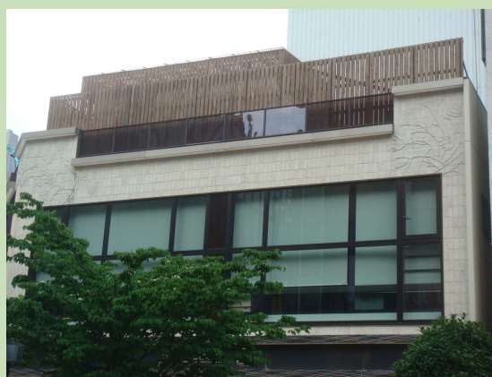
●室外機等をルーバーで覆い、道路から見えにくくなるよう配慮している。(愛知県名古屋市)
