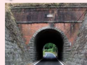
③ 大和街道架道橋
