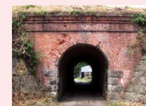
④ 第165号架道橋
