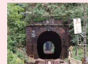
⑥ 坊谷隧道
