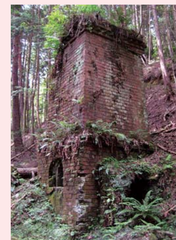
② 煉瓦造構造物
