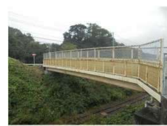
上古屋橋（跨線橋）
