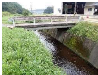
椿亀橋（河川橋）
