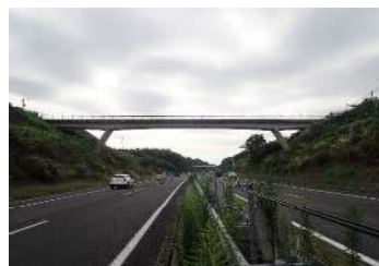
上原北橋 (1039) (跨道橋)
