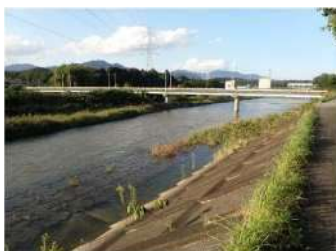
木下橋 (0338) (河川橋)
