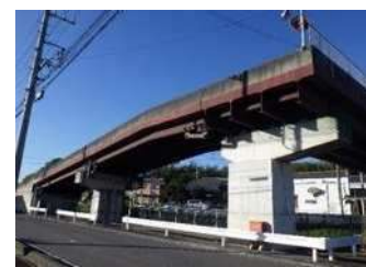
布気跨道橋（跨線橋）
