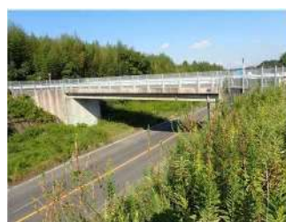
正知浦跨道橋（跨道橋）
