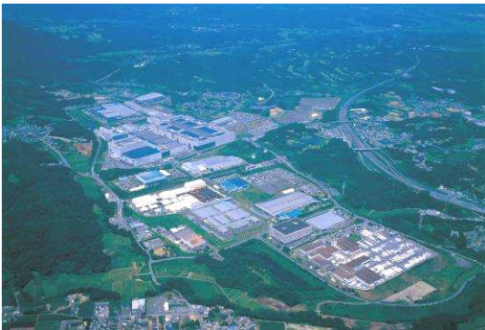
■名阪亀山・関工業団地及び 亀山・関テクノヒルズ
