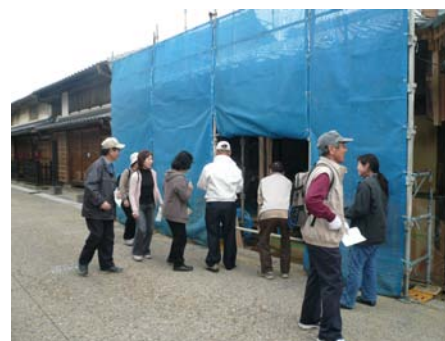
■修理現場公開
