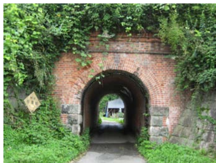
■関西鉄道架道橋
