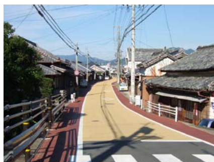
■電線類の事例
