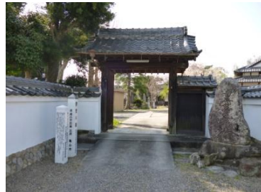
■工事完成【撮影：平成30年3月】
