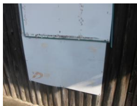
撤去後 【撮影：平成30年2月】
