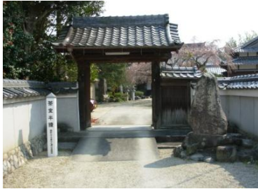
■工事着工前【撮影：平成29年12月】
