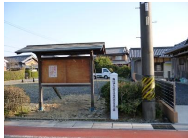
■工事完成【撮影：平成30年3月】
