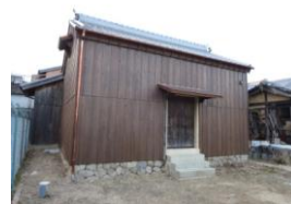
▲修理後の展示棟(土蔵) 【撮影:平成30年2月5日】
