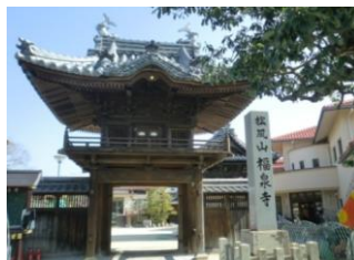
■工事完成【撮影:平成30年3月】
