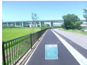
整備前状況【撮影：平成29年7月】
