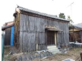
▲修理前の展示棟(土蔵) 【撮影:平成28年12月15日】
