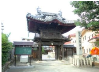
■工事着工前【撮影:平成29年7月】
