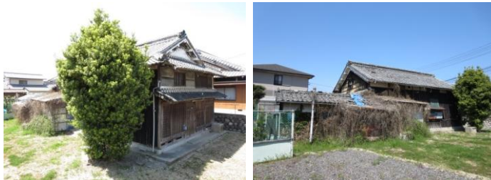
旧佐野家住宅外観【撮影:平成26年7月】
