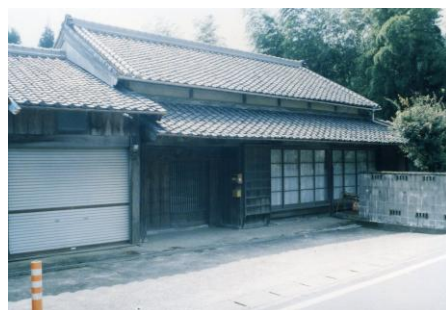
■大和街道沿いの民家
