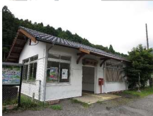
現加太駅舎（昭和11年建築・約102㎡）
