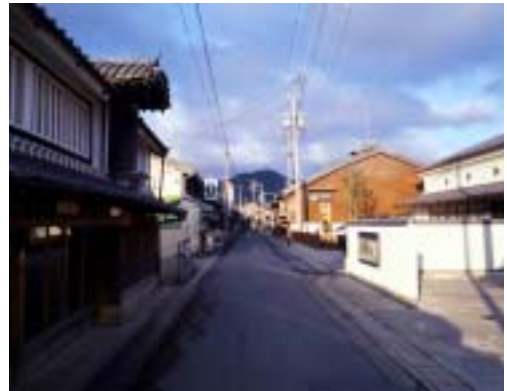
道路舗装及び電柱の撤去前の関宿中町
