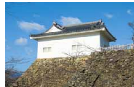
旧亀山城多門櫓 「平成の大修理」
